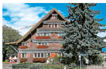
Wohnhaus Schläppliweg 15, Buchs
