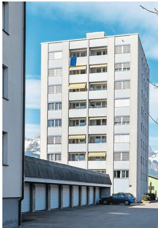
Das markante Hochhaus im Gebiet Flös: Der Verwaltungsrat der Ortsgemeinde Buchs möchte vom Vorkaufsrecht Gebrauch machen. Bild: Heini Schwendener
