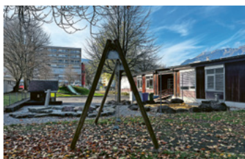
Brunnenstrasse 4 Schul - Pavillion Parzelle Nr. 2788
