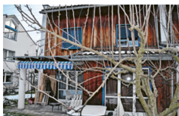
Kanalweg 24 Einfamilienhaus Parzelle Nr. 2296 6-Zimmer-Wohnhaus
