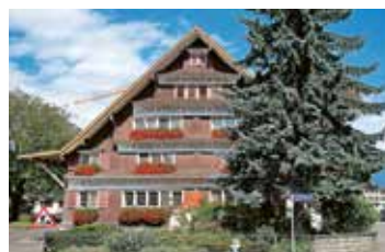
Wohnhaus Schläppliweg 15, Buchs
