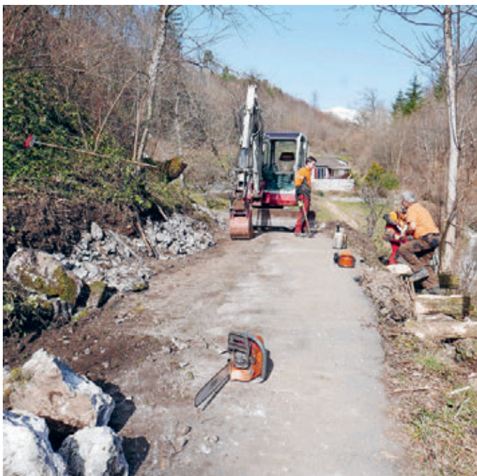
Schenkenalpweg, Felsabbau und Holzverbau aus Robinienholz
