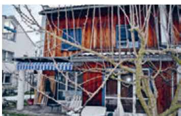
EFH Kanalweg 24, Buchs
