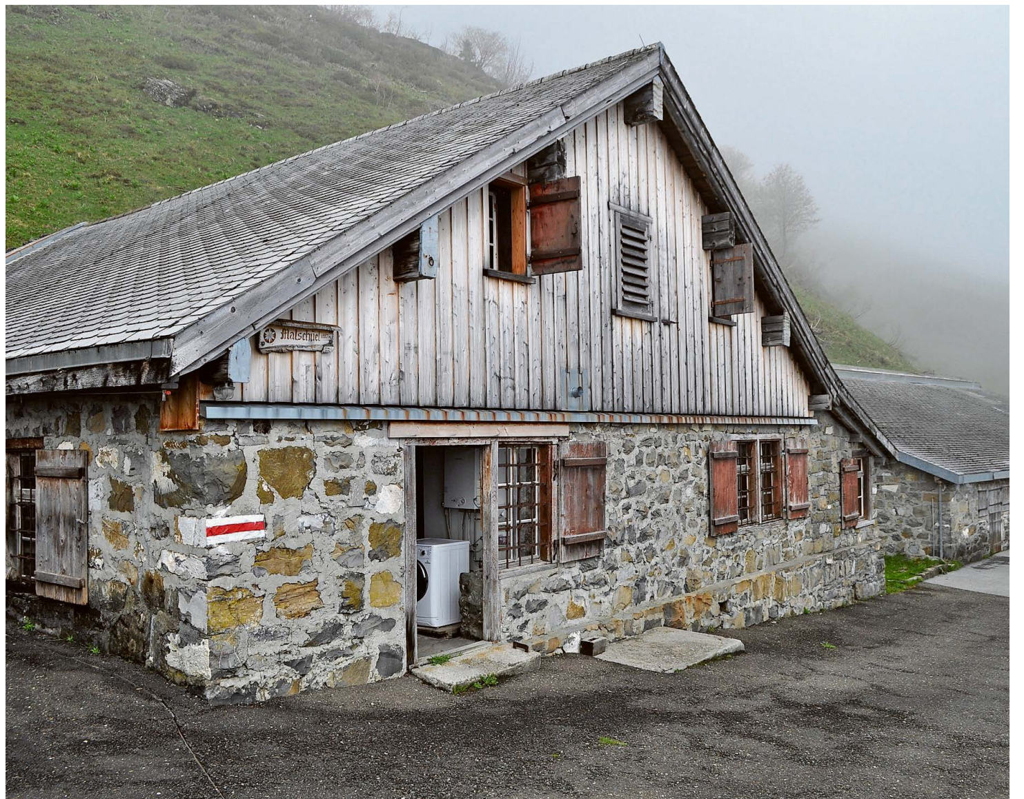
Die Hirtenunterkunft auf Malschüel wird für 550 000 Franken saniert.
