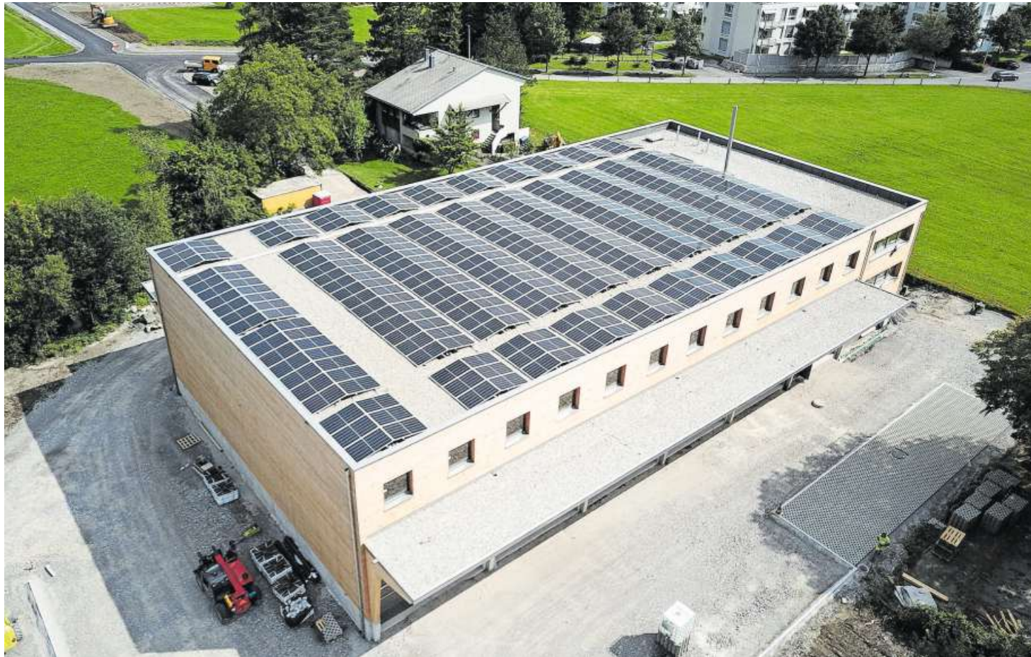
Die Fotovoltaikanlage auf dem Dach des neuen Werkhofs ist ein weiterer Beitrag zur Energiestadt Buchs.
