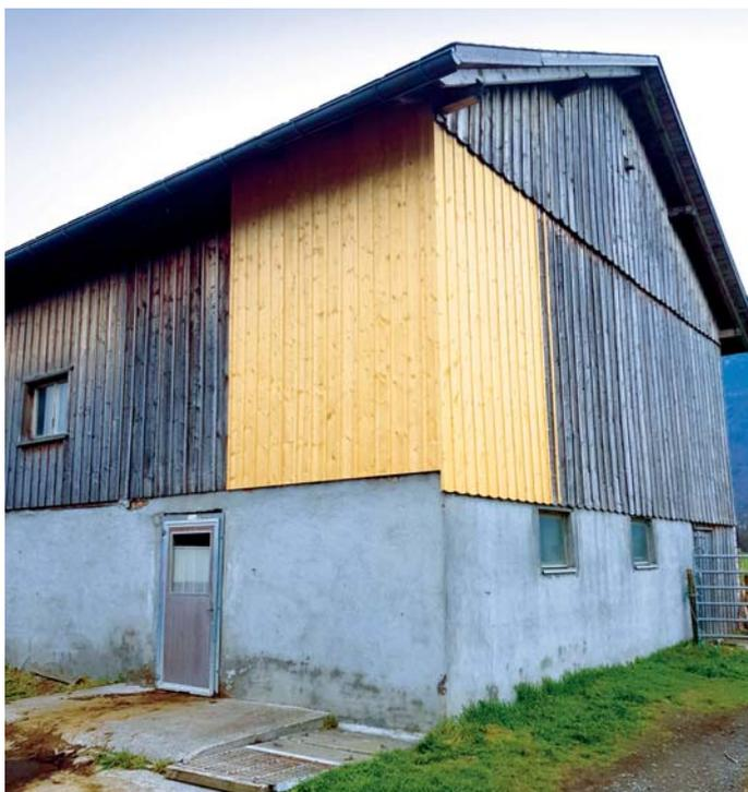
Die grosse Schneelast drückte auf Malschüel und Malbun ganze Gebäudeteile zusammen, verformte Dachrinnen und deckte Dächer ab. Lokale Handwerker reparierten die Schäden in den Sommermonaten.
