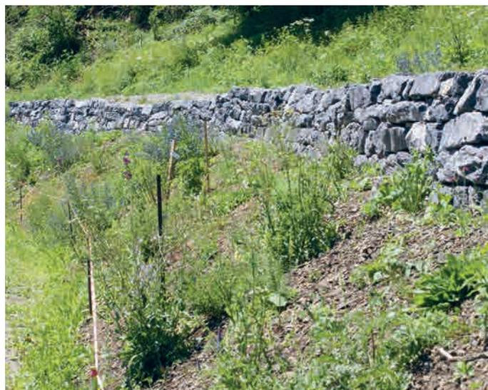
Entlang des Waldrandes wird eine 60 Meter lange und ein Meter hohe Trockenmauer aus Bruchsteinen wiederaufgebaut. Auf der Mauer und in den Ritzen, Spalten und Hohlräumen findet eine Vielzahl von Tier- und Pflanzenarten Schutz und Lebensraum.
