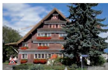
Wohnhaus Schläppliweg 5, Buchs
