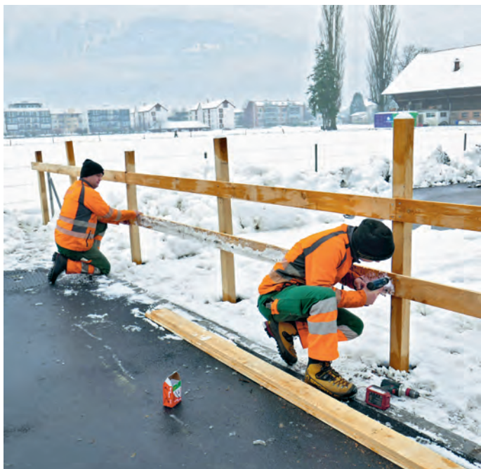
Zaunbau beim neuen Werkhof Rietli
