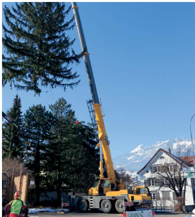
Gartenholzerei mit Grosskran
