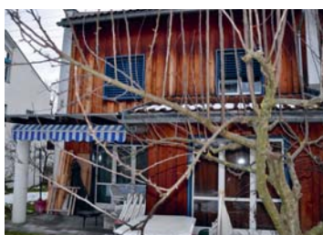
EFH Kanalweg 24, Buchs
