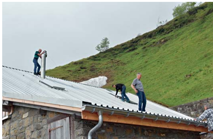
Mängel-Kontrolle auf dem Dach
