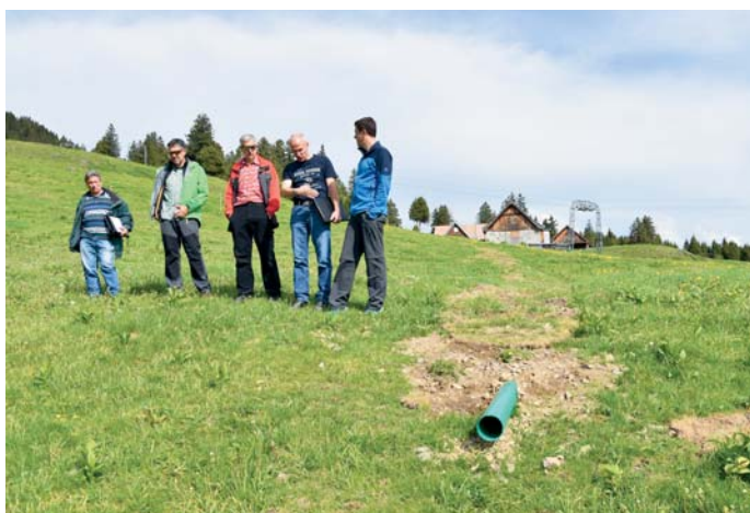
Wasserableitung Alp Malbun
